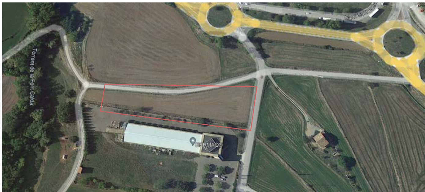
Vista aèria de la zona industrial
