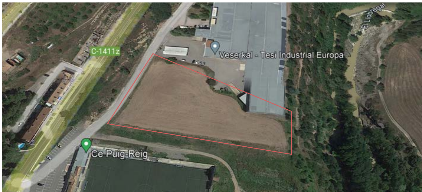
Vista aèria de la zona industrial
