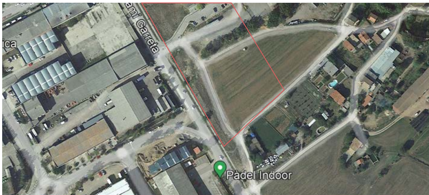
Vista aèria de la zona industrial
