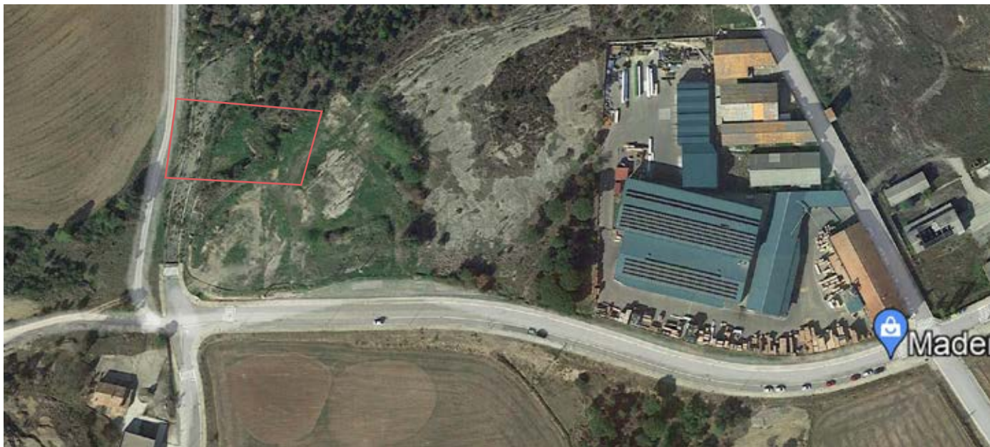
Vista aèria de la zona industrial
