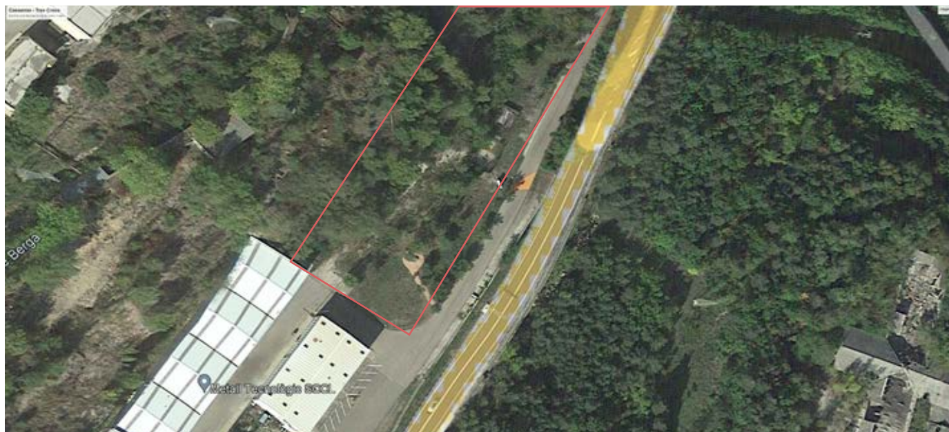
Vista aèria de la zona industrial
