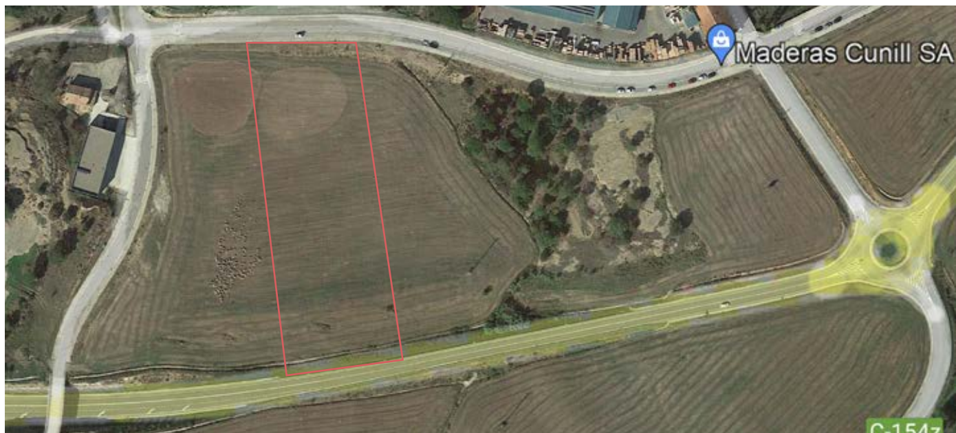
Vista aèria de la zona industrial
