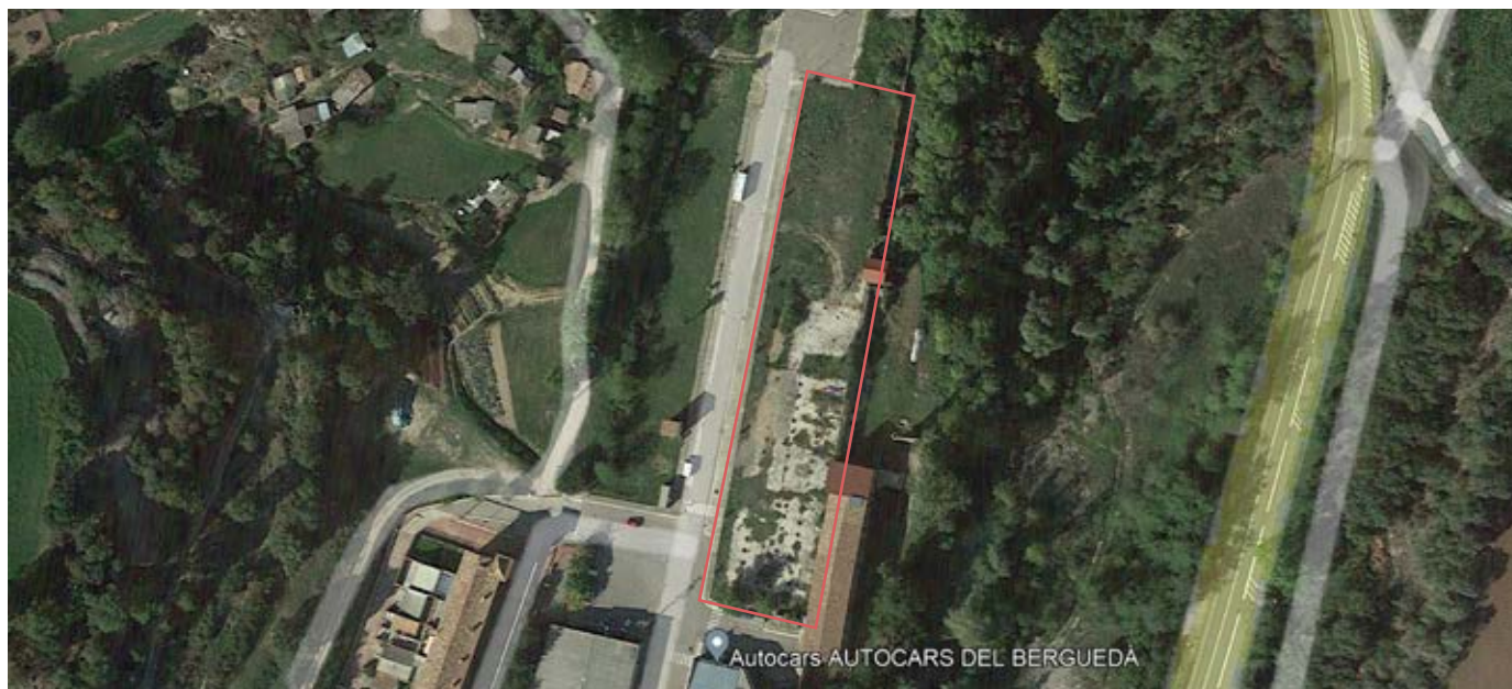
Vista aèria de la zona industrial
